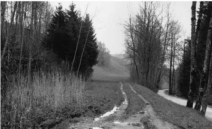
Bahn-Planum ausserhalb des Waldes östlich des Staltentunnel-Ausganges Seite Ebersecken; Zustand 1972. Foto Verfasser
