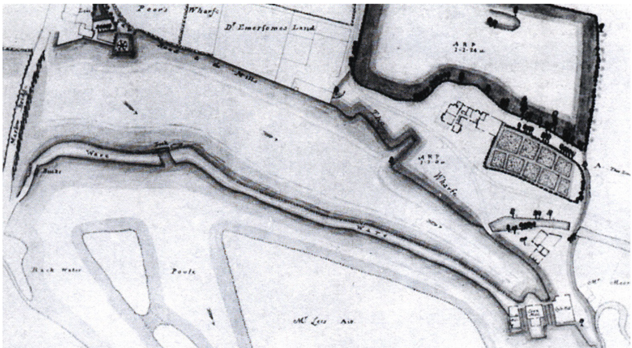
Abb. 6: Das Wehr der „Marlow Mill“ an der Thames. Links unten ist die Mühle mit zwei Wasserrädern zu erkennen. Die Flutschleuse für die Schifffahrt befindet sich links der Mitte im Damm. Ihr gegenüber am linken Ufer ist die Winde zu erkennen, um die das Seil gelegt werden musste, wenn ein Schiff gegen die Strömung durch die Flutschleuse gezogen wurde. Quelle: WILSON 1987: s. 21.
