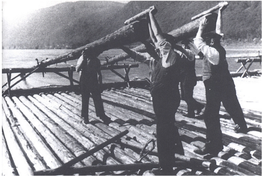
Abb. 69: Die „Streichen“ eines Flosses auf dem Main um 1920. Mit dieser primitiven Steuereinrichtung wurden auch die riesigen Holzinseln des 18. und frühen 19. Jahrhunderts gesteuert. Quelle: KEWELOH 1988: s. 37.
