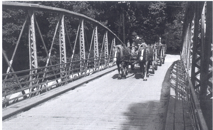
Abb. 4: Vorindustrieller oder industrieller Transport? Ein Fuhrwerk quert auf einer hölzernen Fahrbahn eine Stahlbrücke. Quelle: STRÄHLER 1999: s. 70.
