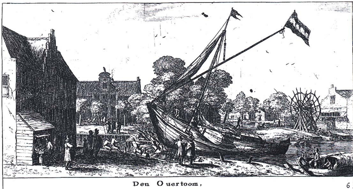
Abb. 14: Ein „ overtoom “. Diese Vorrichtung diente dazu, Schiffe über einen Damm in ein anderes Fahrwasser zu hieven. Die Anlage im Hintergrund besitzt ein grosses Handrad, mit dessen Hilfe kleine Schiffe auf einer schiefen Ebene über den Deich gezogen wurden. Beim „ overtoom “ im Vordergrund scheinen Schiffszieher die Zugarbeit ohne mechanische Hilfsmittel geleistet zu haben. Das Schiff bewegte sich im „ overtoom “ über drehende Rundhölzer. Nur speziell konstruierte Schiffe mit flachem Boden ohne Kiel, so genannte „ damlooper “, konnten ein „ overtoom “ benutzen. Quelle MENZEL 1987: s. 25.
