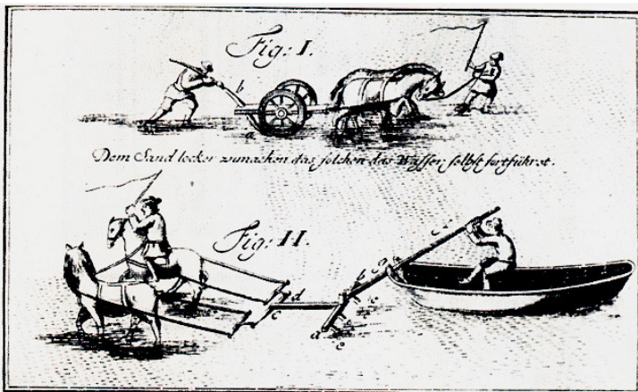
Abb. 48: „Dem Sand locker zumachen das solchen das Wasser selbst fortführet.“ Illustration aus dem „ Theatrum Machinarium Hydrotechnikum “ des Jacob Leupold von 1724. Wie das entfernen von Bäumen, war die Beseitigung von Sandbänken, die sich in die Fahrrinne gelegt hatten, eine wiederkehrende und sehr aufwändige Regulierungsarbeit. Quelle: UHLEMANN 1987: s. 31.
