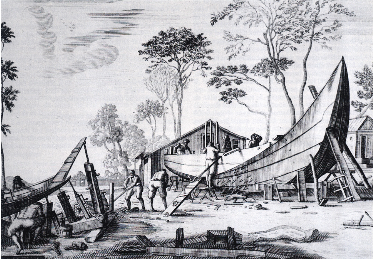
Abb. 53: „Auf der Schiff Matn zue Straszburg“. Diese Darstellung aus dem 17. Jahrhundert zeigt den Bau von zwei „Schnieken“ in Klinkerbauweise. Links im Bild werden einzelne Bretter unter der Hitzeeinwirkung eines Feuers, welches der Werftarbeiter kontrolliert, und mit Hilfe der abgebildeten Drehzwingen in Form gebracht und verspannt. Am Schiffsrumpf rechts lassen sich die einzelnen Bretter erkennen, die sich wie Dachziegel überlappen. Quelle: DESCOMBES 1988: s. 149.
