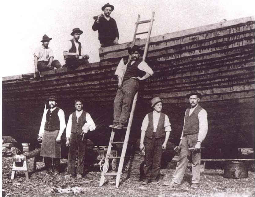
Abb. 58: Eine Baumannschaft in Hard am Bodensee um 1900. Jeder der acht Facharbeiter hält sein Spezialwerkzeug in Händen. Das Schiff ist ein Kravehlbau. Die Fugen zwischen den Läden wurden mit Werg und Pech abgedichtet. Quelle: KINSKY 2000: s. 167.
