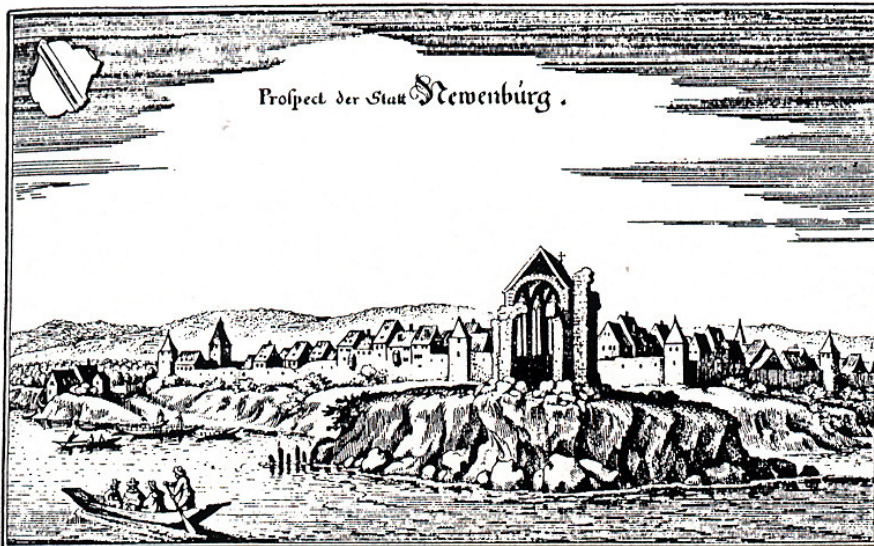
Abb. 45: Durchbruch durch einen Mäander. Ansicht des fast völlig zerstörten Münsters von Neuburg gegen Ende des 17. Jahrhunderts. Die Pfählung rechts, die das Schlagufer des Mäanders vor Erosion hätte schützen sollen, vermochte den verheerenden Durchbruch des Rheins an dieser Stelle nicht zu verhindern. Quelle: KALWEIT 1993: s. 41.
