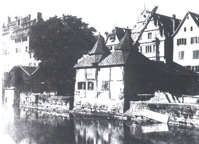
Abb. 83: Der Doppelkran beim Strasbourger Kaufhaus. Aufnahme vor 1854. Diese 1385 erstellte Anlage besass im Innern zwei grosse, hölzerne Räder, in welche die „Räderknechte“ einsteigen mussten, um es mit ihrem eigenen Körpergewicht anzutreiben. Über Flaschenzüge wurden Hanfseile auf die Ausleger geführt, die zusammen mit dem oberen Teil des Daches geschwenkt werden konnten. Quelle: DESCOMBES 1988: s. 82.
