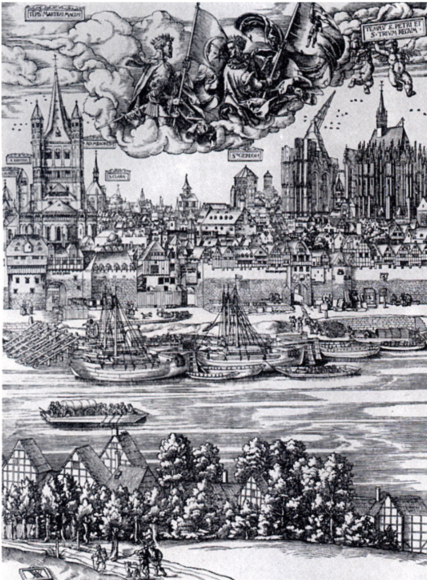
Abb. 84: Die Landestelle von Köln. Ausschnitt aus dem Woelsam-Prospekt von 1531. Der massive Holzrost links im Bild ist ein Eisbrecher, der Eisschollen abweisen und so die Schiffe in seinem Schatten vor Beschädigung schützen soll. Den Rhein quert eine mit Rudern gesteuerte Fähre, die Menschen und ein Fuhrwerk trägt. Das Ufer ist mit Mauern vor Erosion geschützt. Entlang der Stadtmauern lagern verschiedene Güter. Von rechts kommend besorgen Warenträger und Pferdekarren den Warenumschlag zwischen der Landestelle und der Stadt, die sich nur durch die engen Stadttore erreichen lässt. Quelle: BÖCKING 1980: s. 79.
