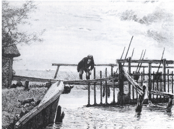
Abb. 12: Ein hölzernes Nadelwehr wird geschlossen. Rechts auf dem Steg sind die einzelnen Nadeln zu sehen, die bei Hochwassergefahr entfernt werden mussten. Rechts ist der Mühlendamm zu erkennen, der mit einer hölzernen Fassung vor Erosion geschützt ist. Es ist offensichtlich, dass solch fragile, hölzerne Nadelwehre in stark fließenden Gewässern mit viel Geschiebe nicht dauerhaft installiert werden konnten. Quelle: WILSON 1987: s. 19.
