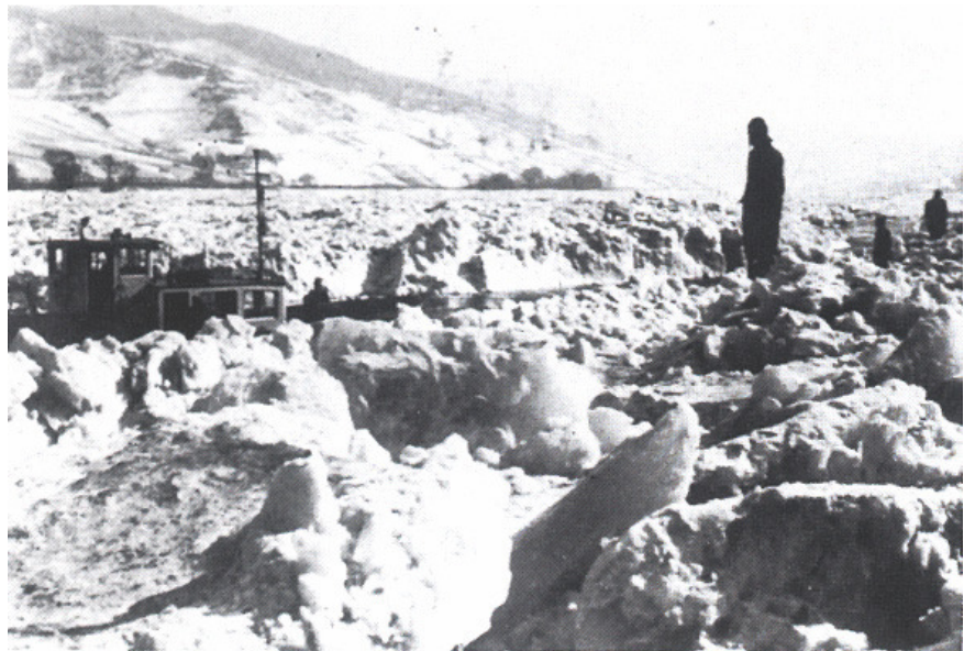
Abb. 29: Februar 1956: Das Eis steht. Der Eisbrecher „Nobiling“ im Einsatz unterhalb von Bingen. Quelle: KALWEIT 1993: s. 140.
