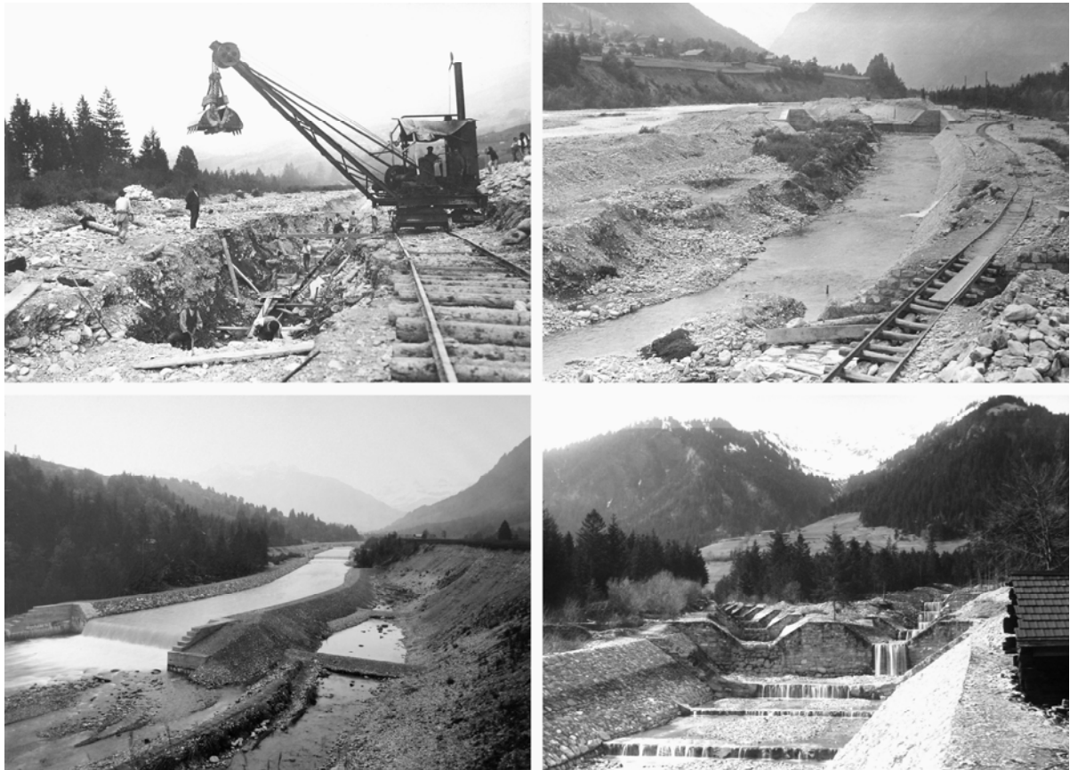
Abbildung 1.3: Verbauungsarbeiten an der Kander (oben sowie unten links) und deren Seitenbäche (unten rechts) in den Jahren 1899 bis 1912 (Fotos: StAB 1911, 1914a, 1914b)
