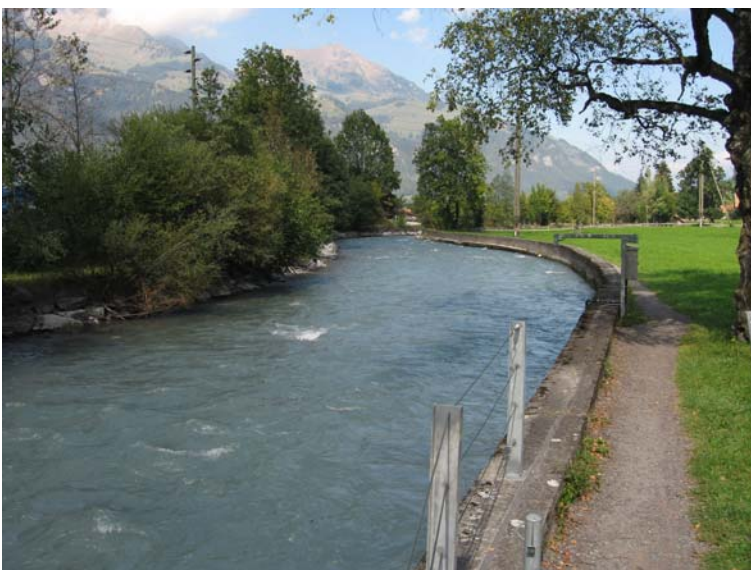
Abbildung A 6: Kander bei der Messstation in Frutigen, Blick Fluss abwärts
