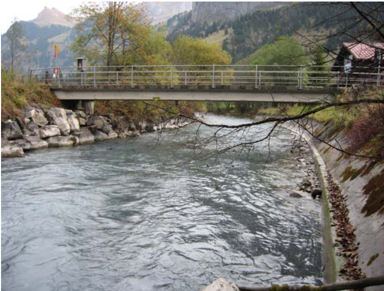
Abbildung A 5: Kander bei der Messstation in Kandersteg, Blick Fluss abwärts
