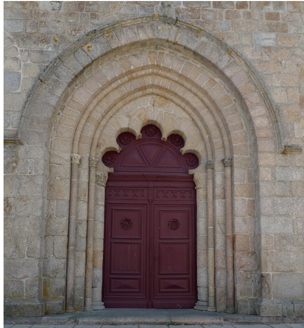
Abb. 20: Westfassade, St.-André-St.-Léger, Meymac, Limousin.
