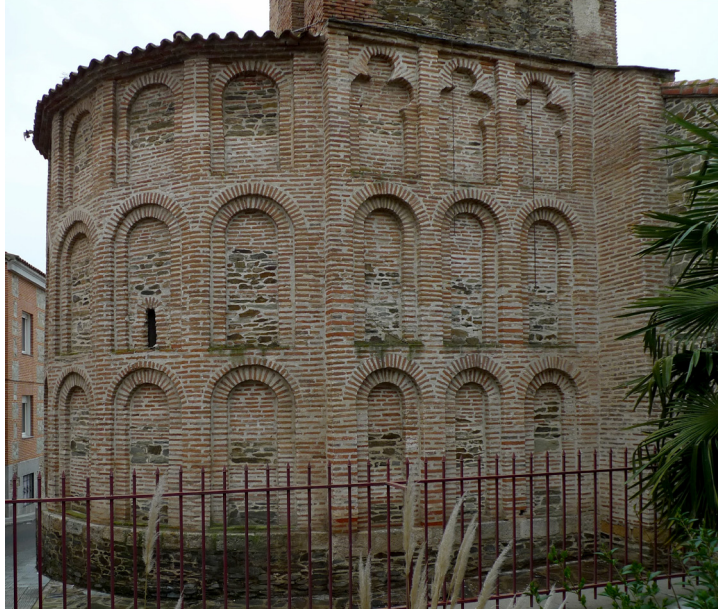
Abb. 43: Nordfassade, Santiago, Alba de Tormes, Salamanca.
