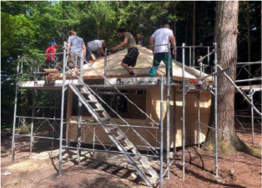
18. Juni 2022: Die Dachdecker
