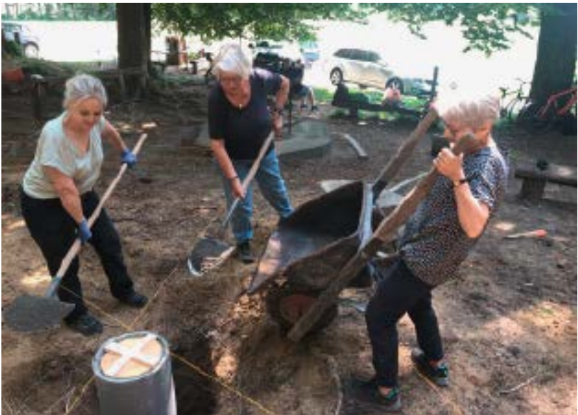
21. Mai 2022: Die Pfostenfundamente werden gesetzt
