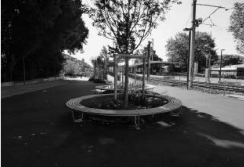
Ende August 2021 konnte der Umbau des Bahnhofs Steinhof abgeschlossen werden (Baukosten: rund 20 Millionen Franken) (Foto: Viktor Kälin)
