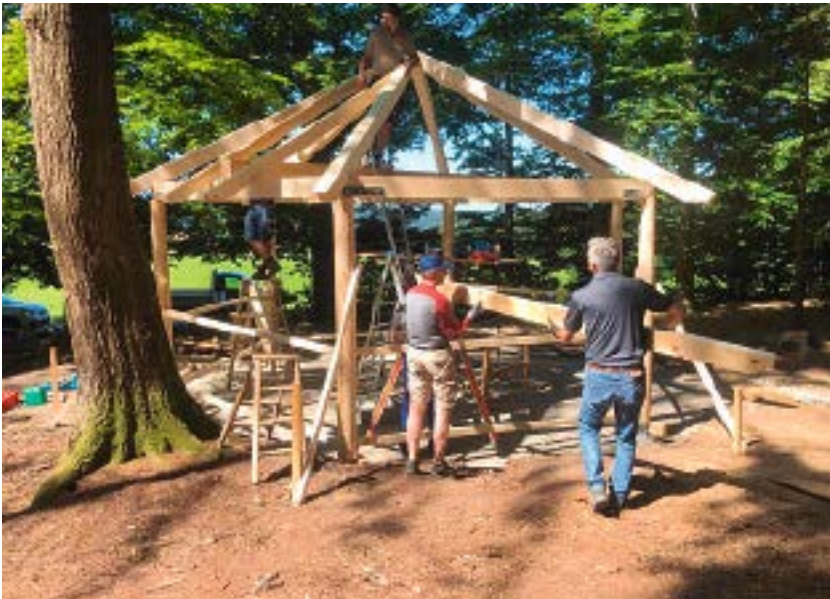
11. Juni 2022: Die Dachkonstruktion entsteht
