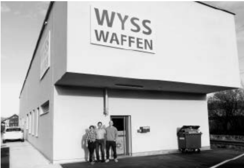
Wyss Waffen: Daniel und Erica Wyss, mit Sohn Bruno, konnten nach langer Planung die neue Geschäftsliegenschaft an der Kirchbergstrasse beziehen (Foto: Viktor Kälin)
