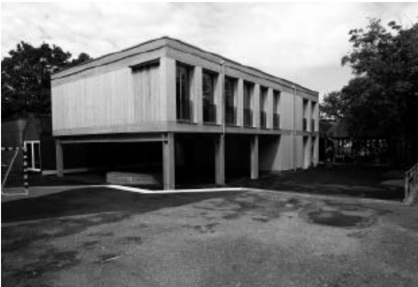
Kindergarten: Der neue Kindergarten am Neuhofweg wurde mit modularen Bauelementen erstellt (Foto: Viktor Kälin)
