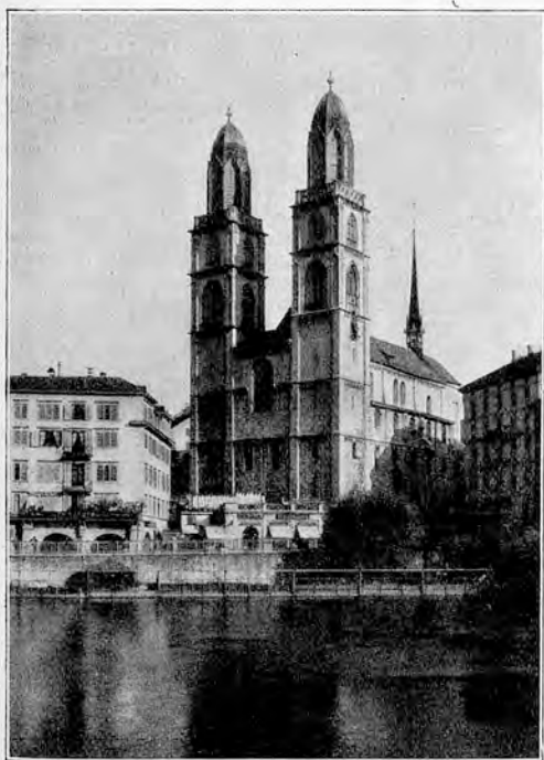
Zürich, Grossmünster, erbaut 1100-1300.
