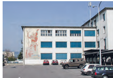
Gesamtaufnahme der Motorfahrerkaserne, 2017.
