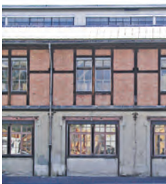
Fassadenausschnitt des Baus Nr. 417, 2022.
