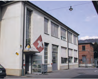
Südansicht des Anbaus Nr. 401, 2004.
