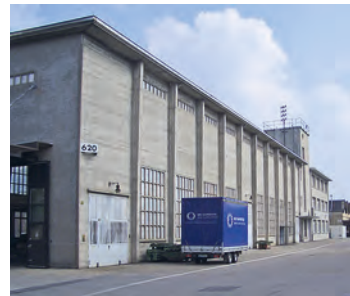
Gesamtaufnahme der Südwestfassade der Gebäude 619 und 620, 2017.
