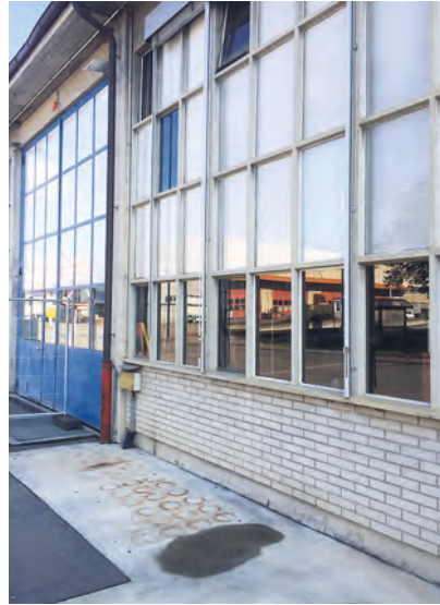
Ein Ausschnitt aus der Ostfassade der südlichen Panzerwerkstatt, 2014.
