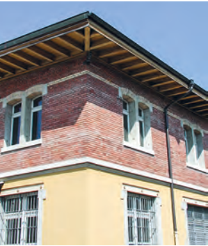
Gebäudedecke des ehemaligen Zeughauses, 2017.
