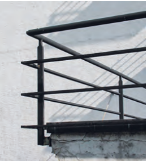
Detail des Balkons der Motorfahrerkaserne, 2004.
