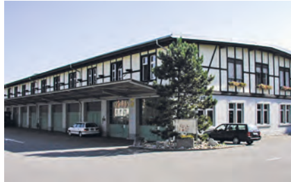
Westfassade und Südfassade des Baus Nr. 503
