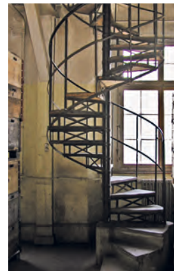
Wendeltreppe im Inneren, 2004.
