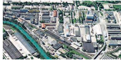
Die Luftaufnahme des Areals kurz nach dem Bau der KVA zeigt das Gebiet des Rundgangs: In der Mitte der ehemalige Hauptzugang ins Areal. Im Vordergrund die Bauten entlang der Uttigenstrasse, rechts unten die Panzerbrücke (RUAG 2005).
