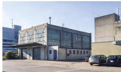
Das Versuchsgebäude 2017. Inzwischen wurde das grazile Vordach mit Wellteernit verkleidet.
