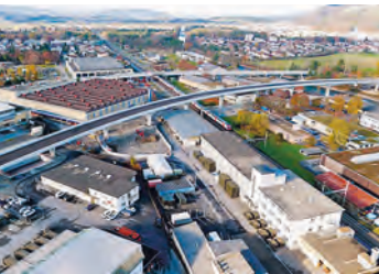
Quer durch das Bild zieht sich die Nordumfahrung, eröffnet 2017. In der rechten Bildhälfte sind südöstlich der Brücke nacheinander die Hallen 627, 619 und 620 zu erkennen (Bänziger Partner).
