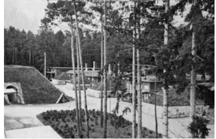
Blick über die Anlage Feuerwerkerstrasse 1948 (Foto: M+F Thun).
