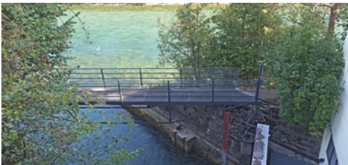
Steg unterhalb des Kraftwerks, 2022 (Foto: Autor).
