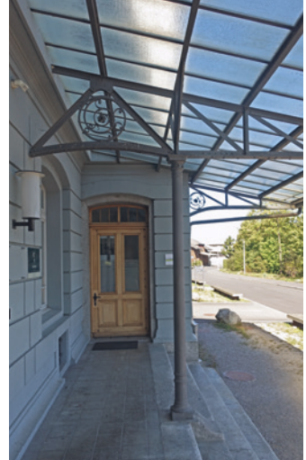
Vordach des Gebäudes Nr.25, 2022 (Foto: Autor)
