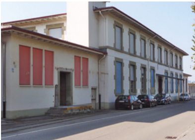
Uttigenstrasse 35–37, 2016 (Foto: Kantonale Denkmalpflege).
