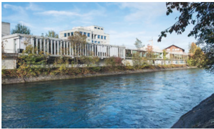
Aareseite der der «Inital Sprengstoff-Anlage» (ISF) vor dem Umbau (Foto: Kocher & Minder).
