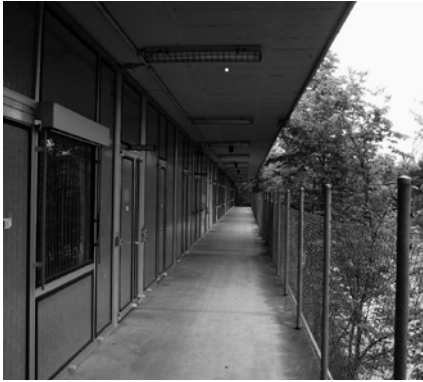
Aarefassade der «Inital Sprengstoff-Anlage» (ISF) vor dem Umbau (Foto: Kocher & Minder).
