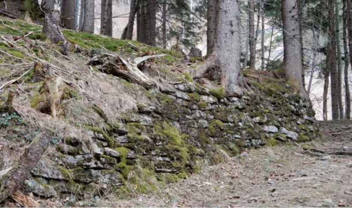
Trockenmauer oberhalb von Chälen
