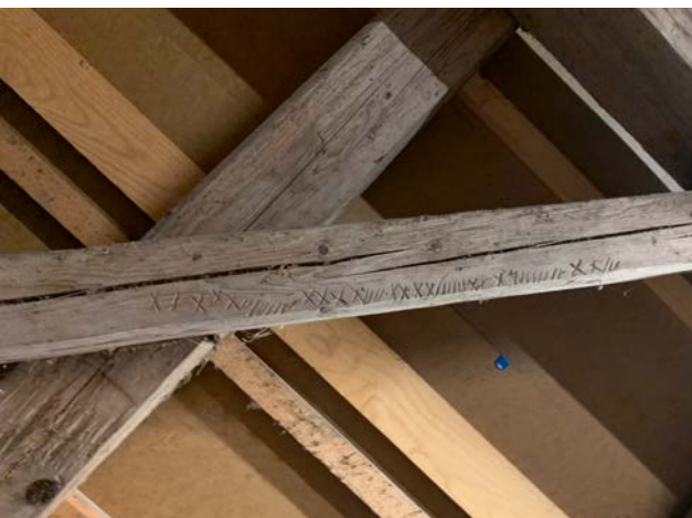
Abbundmarken im 2.Obergeschoss und im Estrich
