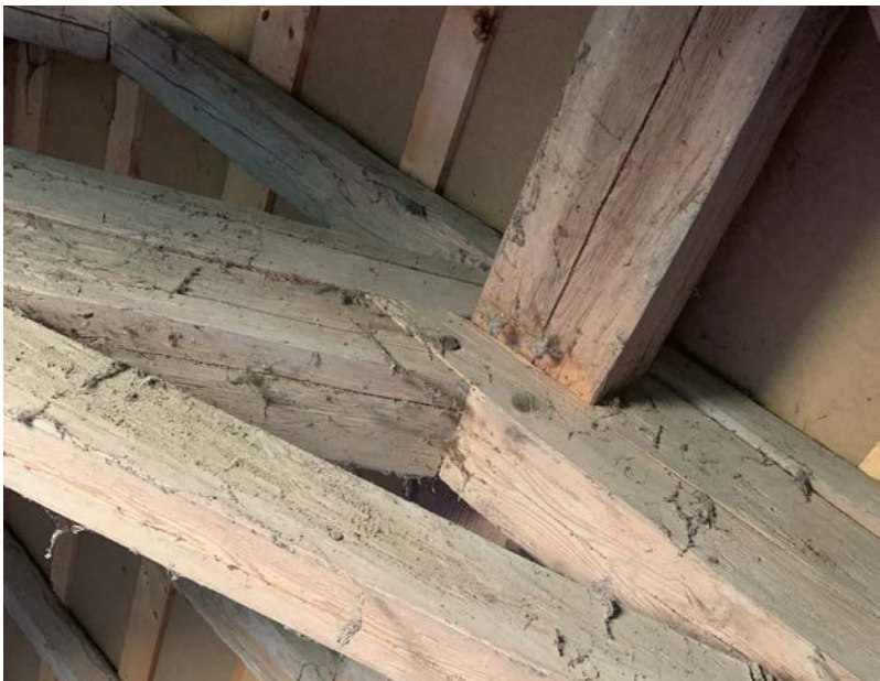
Beispiel für Holznagelverbindungen
