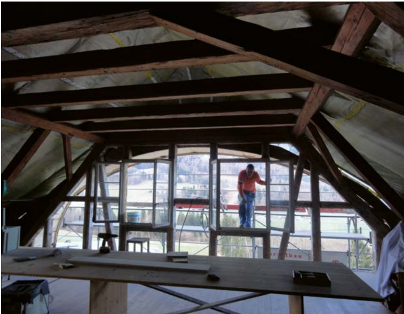
Umbau und Isolation der Fassade 2012 (Foto: Heidi Wendler)
