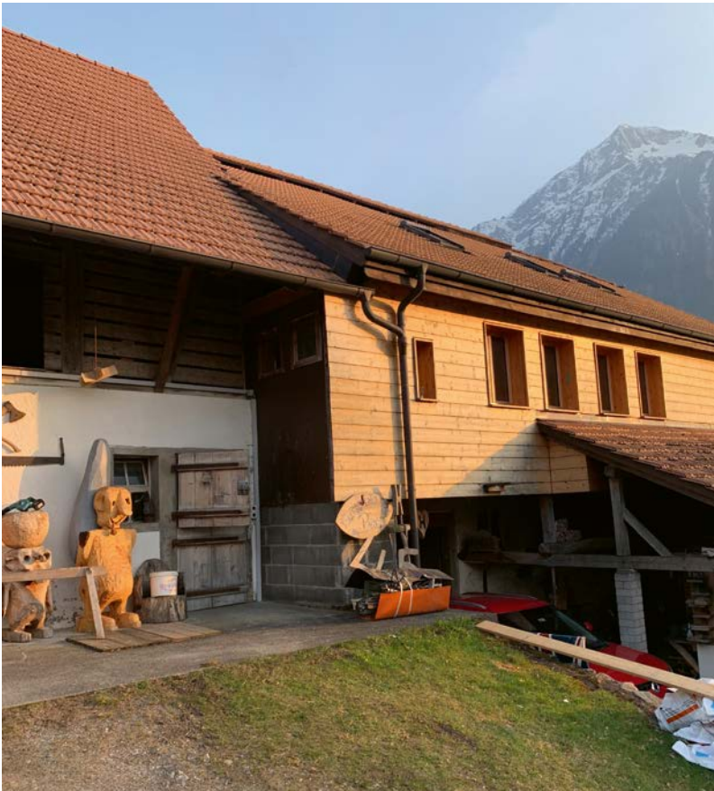
Übergang von der Scheune in den Wohnteil
