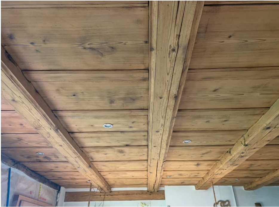
Gehobelte Deckenbalken
