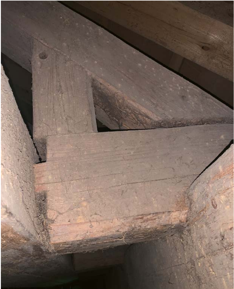
Zapfenverbindung in der Scheune
