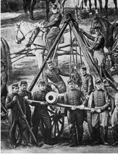
Dreibein mit Seilwinde, 900 kg-Geschütz Wasserkessel mit Putz- und Stopfkolben
