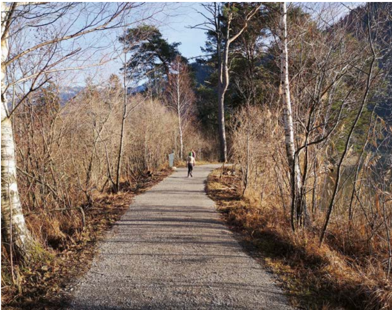
Uferweg Weissenau, Dammschüttung (Foto: Andreas Fuchs)
