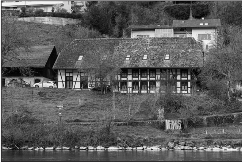
Die Liegenschaft des ehemaligen Restaurants «Rudolf von Erlach» prägt zusammen mit der historischen Neubrügg das Ortsbild von Bremgarten.
