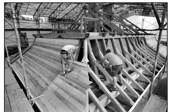
Sanierung des Dachstocks unter einem riesigen Notdach. (Archivbild Wecker 2008)
