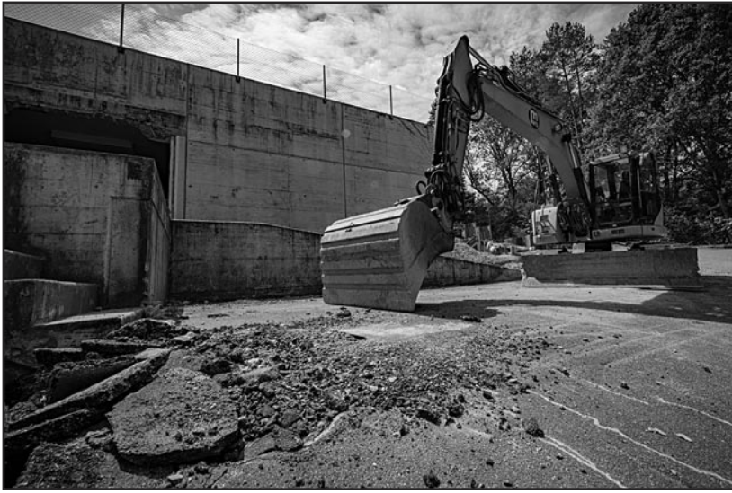
Bis 2025 sollten die Arbeiten für die vierte Reinigungsstufe abgeschlossen sein. mon
