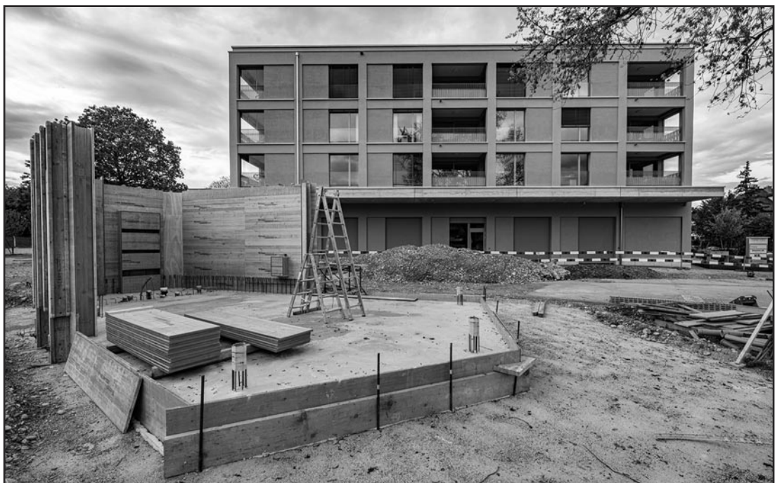
Die Arbeiten für den neuen Dorfplatz samt Pavillon sind in vollem Gang.
