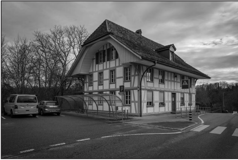
Nordwestansicht des 1833 erbauten Schulhauses.
