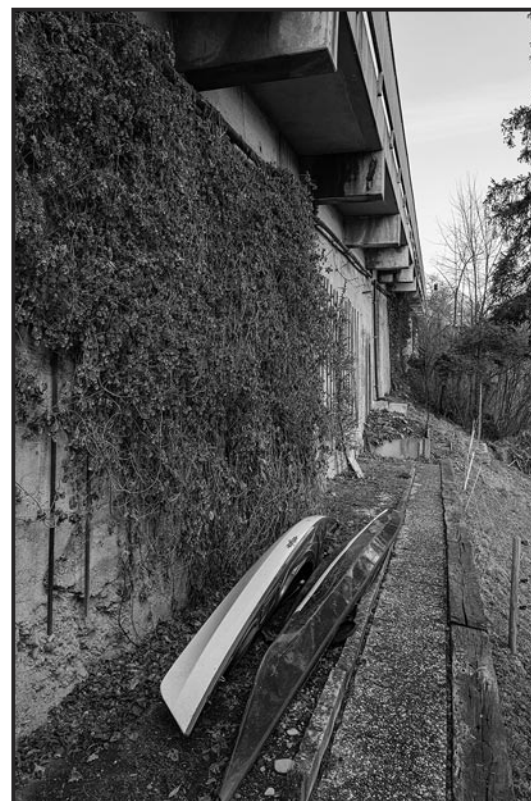
Ein Lehnenviadukt stützt Strassenabschnitte an steilen Hängen. mon
