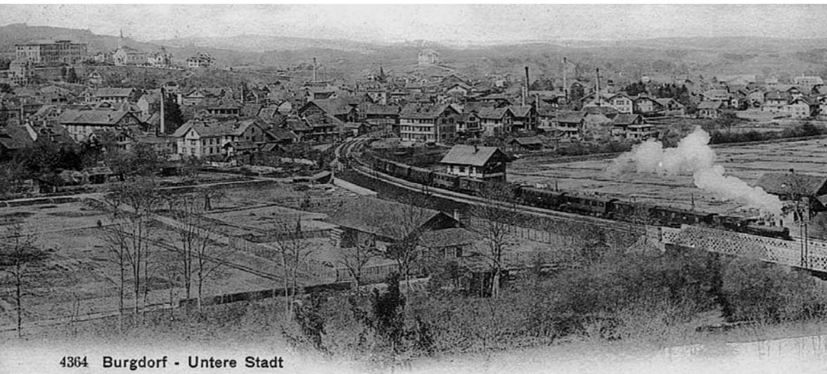
Ein Schnellzug fährt Richtung Olten über die von 1856 stammende, eiserne Gitterbrücke. Erkennbar ist davor die für die Doppelspur 1895 in ähnlicher Art gebaute zweite Brücke (Postkarte um 1910)
