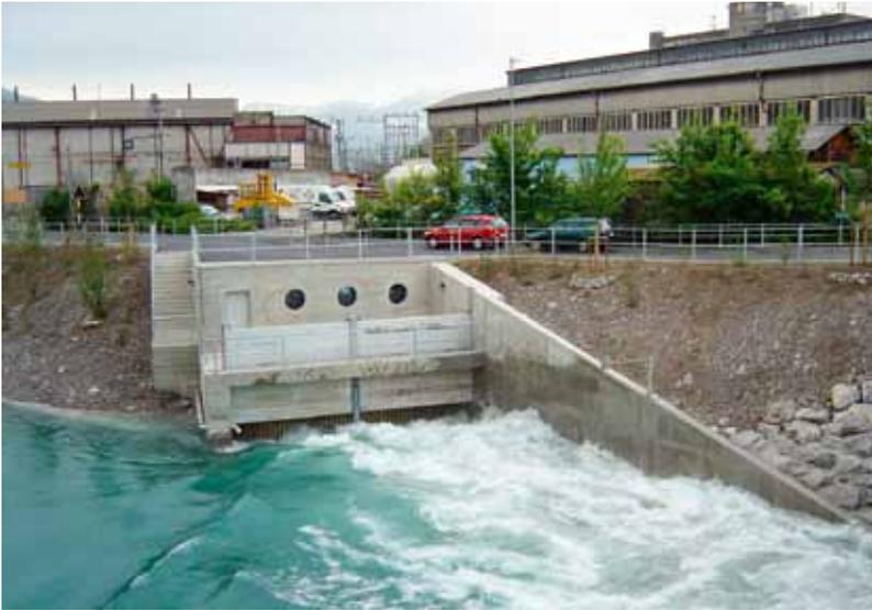
Auslaufbauwerk bei einem Ausfluss aus dem Stollen von knapp  $90\text{m}^3/\text{Sek.}$  während den ersten Tests. (Quelle IC Infraconsult)
